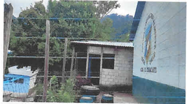
montaje de lamina en AULA
