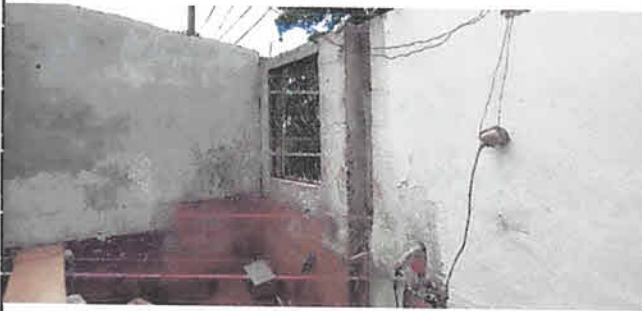
REPELLO EN COCINA, CAMBIO DE LAMINA Y ESTRUCTURA.
