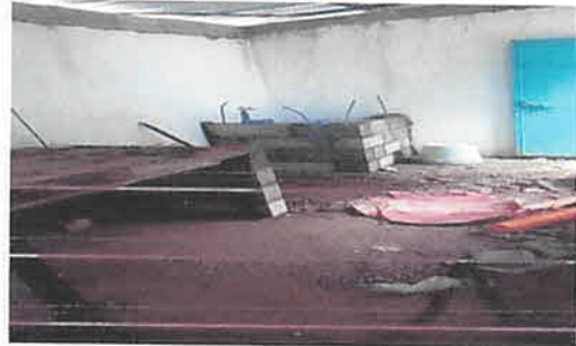
CONSTRUCCION DE PILA, MESON Y PISO.
