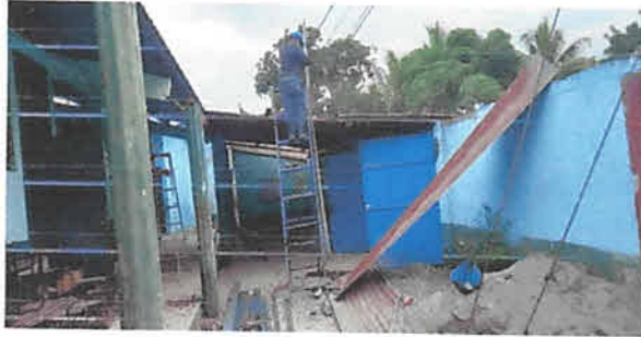
desmontaje de lamina en galera
